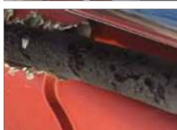
Трубопровод под каучуковой изоляцией с защитой из фольги
