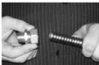
Рис 2 Вставляем в трубу фитинг до упора
